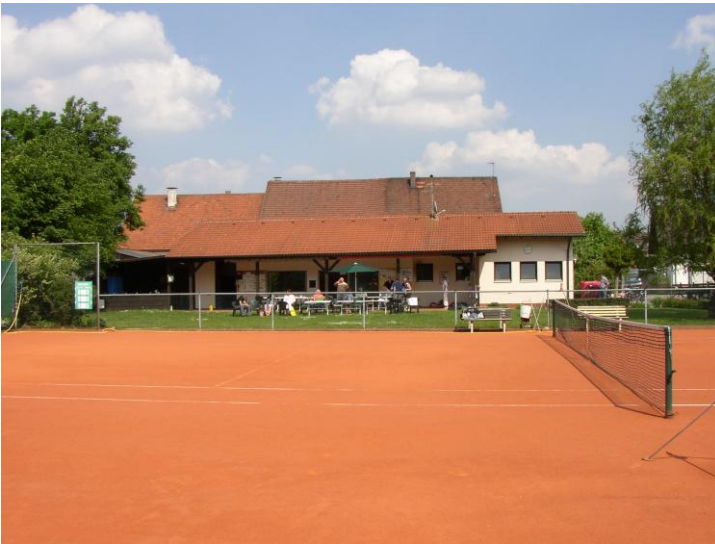
Blick über die Tennisanlage auf das Vereinsheim
